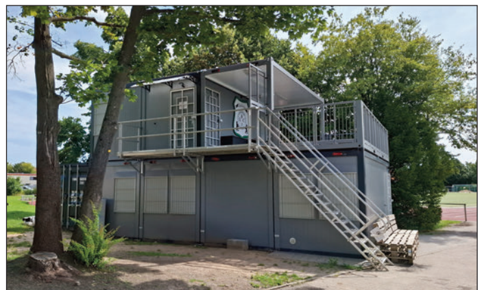
Das Vereinsheim auf dem Sportplatz Halker Zeile und drei Felder der Sportanlage wurden nach 20 Jahren saniert. Foto: Heimann
