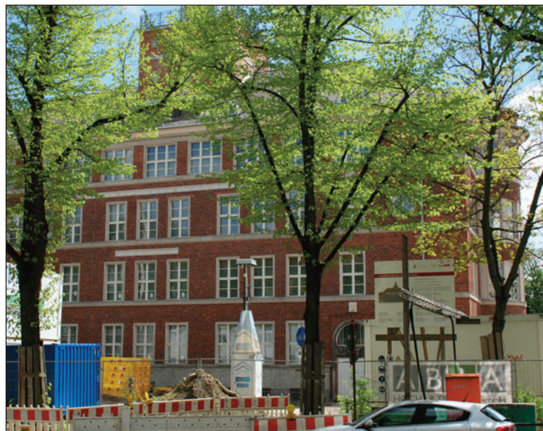
Das Luise-Henriette-Gymnasium ist seit acht Jahren eine Baustelle – und seitdem ohne Schüler. Foto: Bothe
